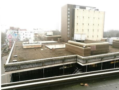
Dach des VMP5 Foto: eigene Darstellung
